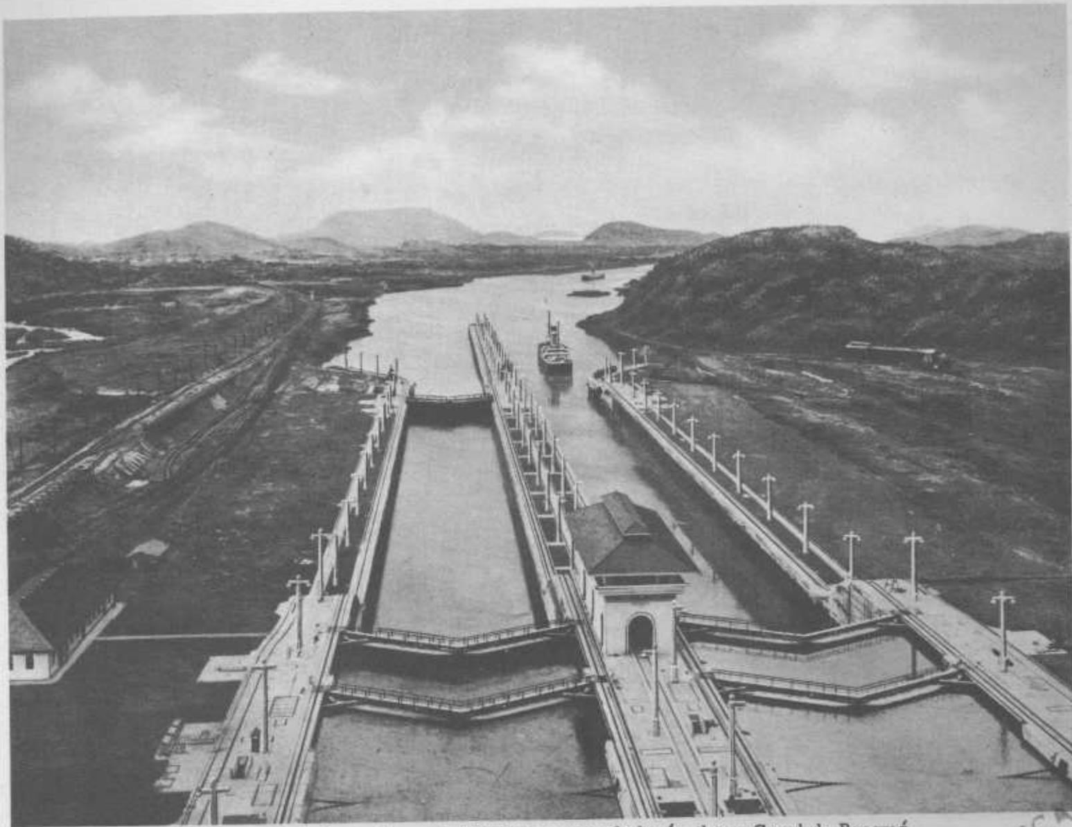
Vista general de las esclusas de Miraflores, mirando hacia el sur, Canal de Panamá General View, Miraflores Locks, Looking South, Panama Canal
