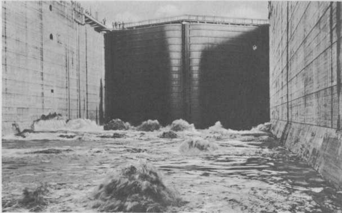
Llenando la esclusa superior de Miraflores, Canal de Panamá Filling upper Miraflores Lock, Panama Canal
